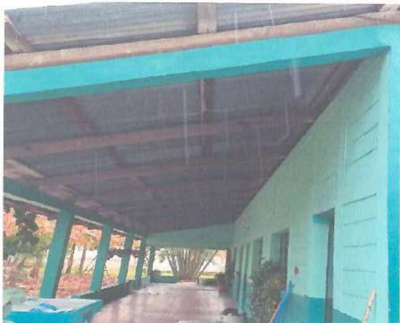
Foto 1: Tamaño del edificio a mejorar en interior y exterior.
