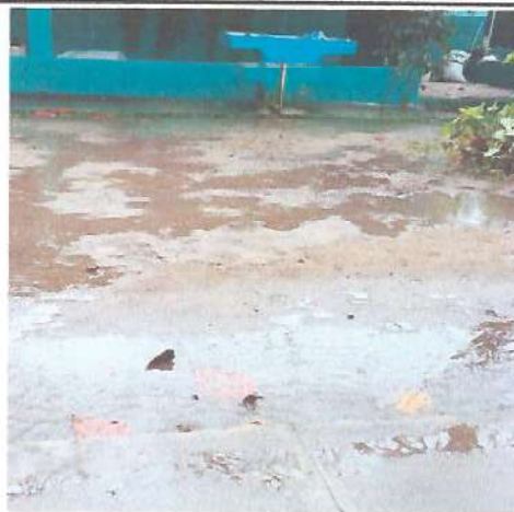
Foto 2: Losa para mejorar el patio.
