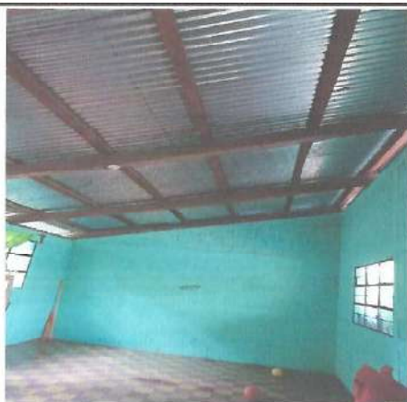
Foto 3: Interior de las aulas a mejorar.
